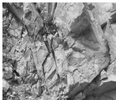
图10 被震裂张开的无充填型结构面
