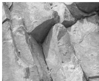
图 1 岩层层面被震裂拉开错动
