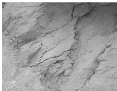
图2 岩体裂隙面被震裂拉开
