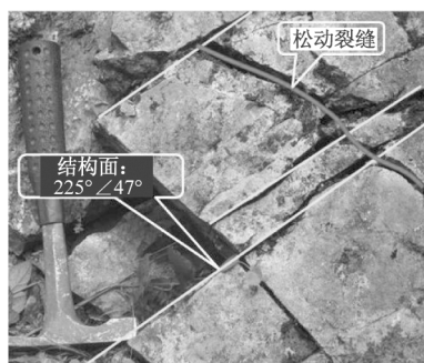
图4 松动裂缝切割结构面
