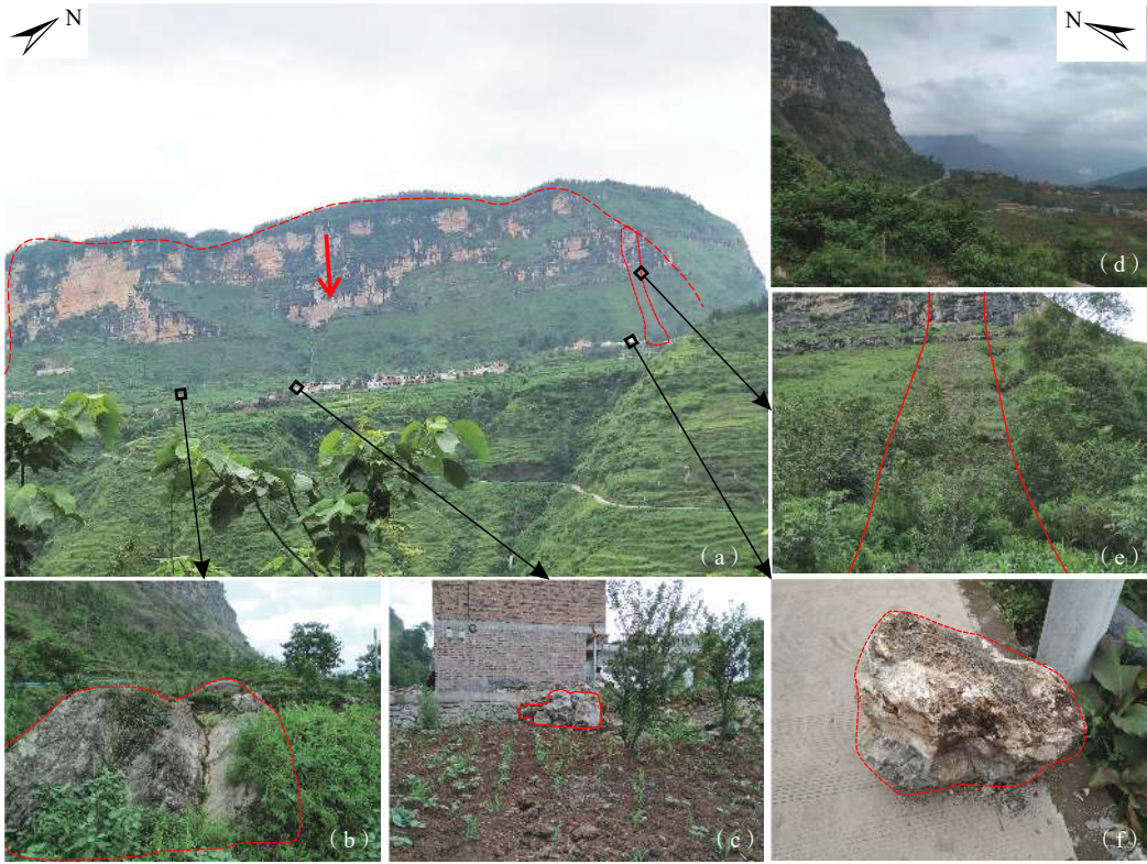
图 2 独家寨崩塌变形破坏特征
