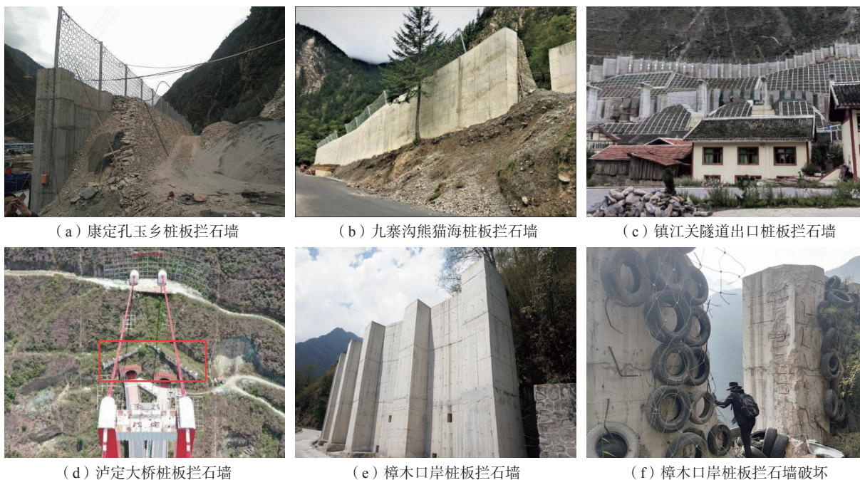
图 1 典型桩板拦石墙结构
