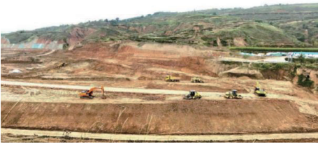
图 10 蓄水池工程开挖老滑坡前缘
