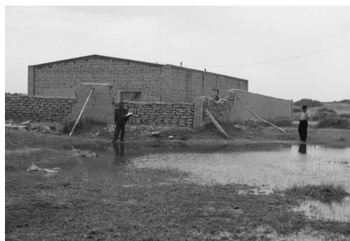
图 7 地下水上升对居民点造成危害
