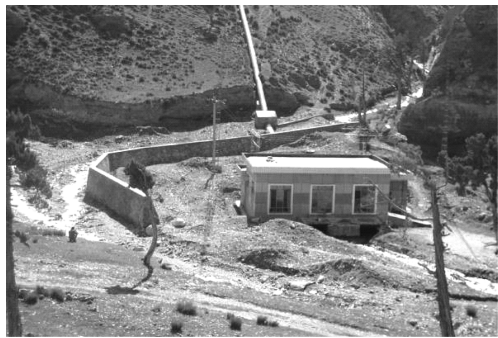
图 3 被泥石流冲毁、淤埋过的水电站
