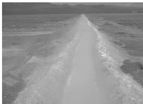
图 11 利用天然土渠引排污管道污水
