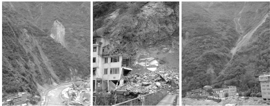
图 4 宝兴县城周边因“4·20”地震诱发的滑坡(左)、崩塌(中)、泥石流(右)灾害
