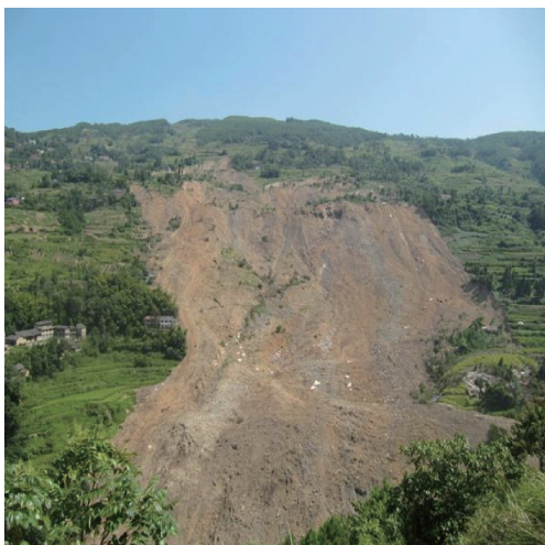
图4 龙王村滑坡全貌
