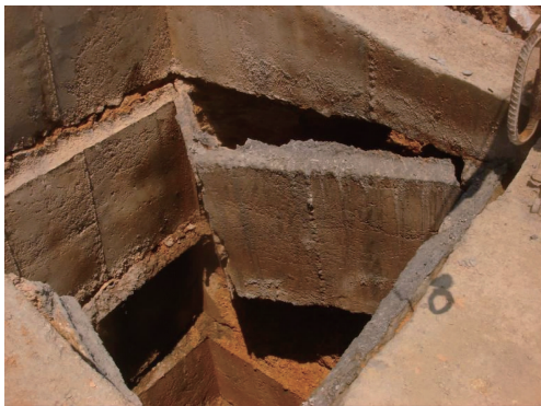
图15 抗滑桩护壁错位
