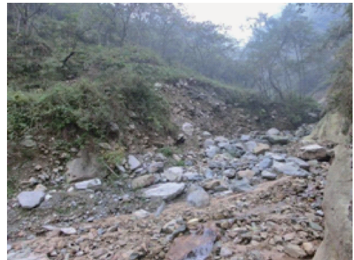
图 5 朱扎沟主沟道沟岸崩滑物源
