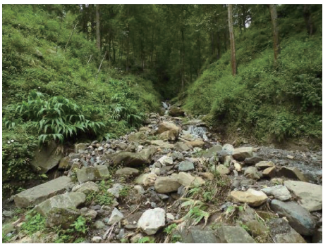
图 5 支沟沟道内堆积物
