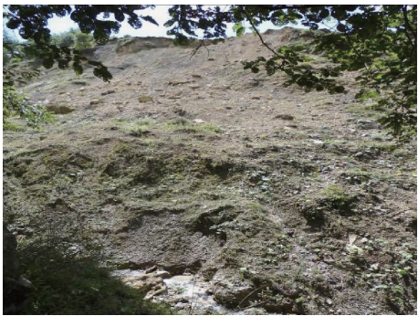
图 6 沟道两岸岸坡松散堆积物
