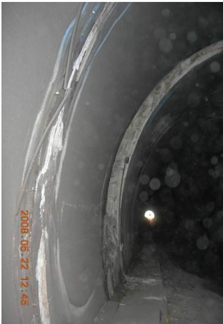
图 2 白云顶隧道衬砌环向错台
