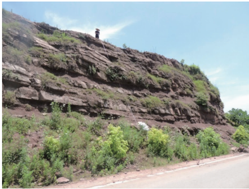
图 11 反向坡差异性风化
