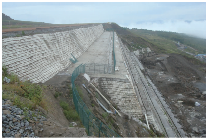
图1 加筋土回填竣工图
