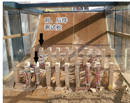
图4 特氟纶薄膜铺设实物图
