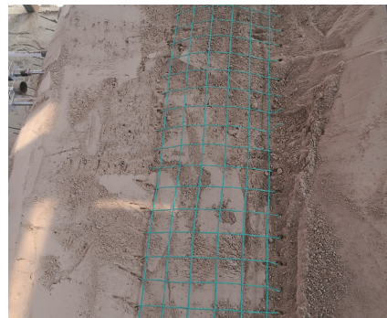
图5 模拟加筋材料铺设实物图
