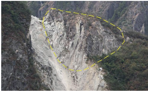
图9 夺嘎下游侧崩塌体中岩体沿支点倾倒运动
