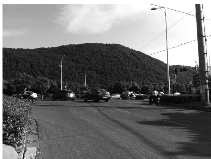
图 5 2014 年 6 月 20 日,施工 10 年后实景照片
