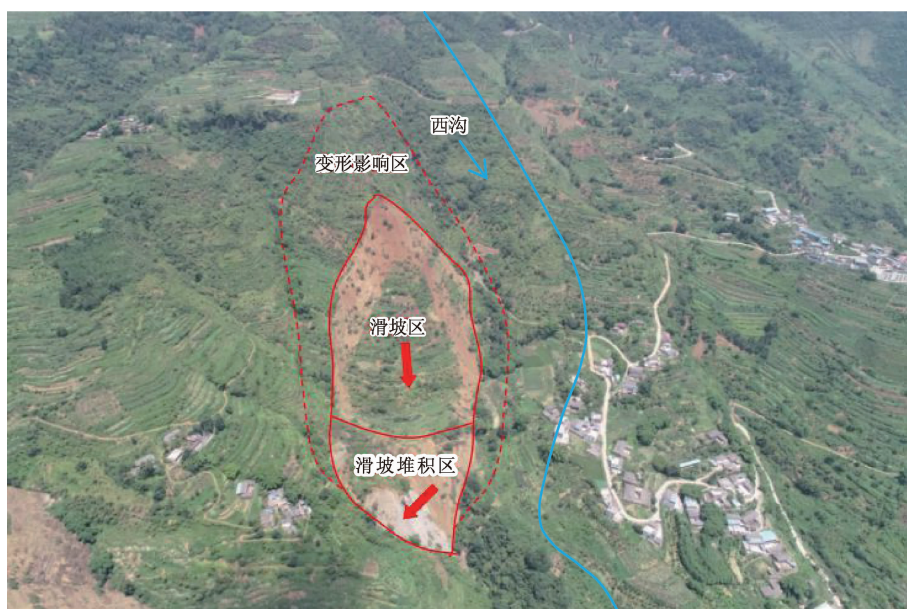
图 1 康家坡滑坡全貌图
