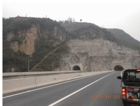
图9 治理后隧道出口外貌
