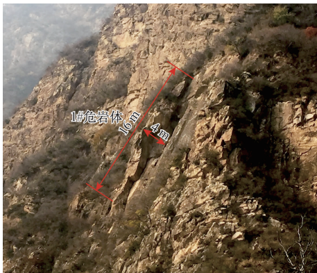
图 4 1#危岩体实地照片 Fig. 4 Picture of 1# dangerous rock mass
