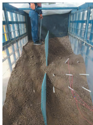
图1 锚杆布置安装
