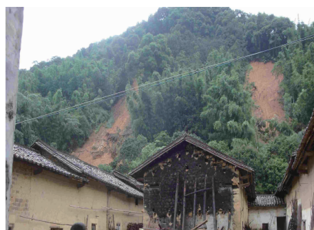
图 9 从化区温泉镇中田村沈山下社 11 号北侧边坡
