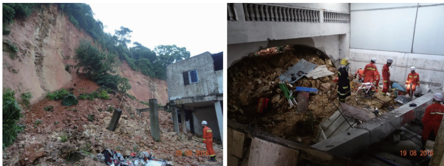
图 7 番禺某山体崩塌
