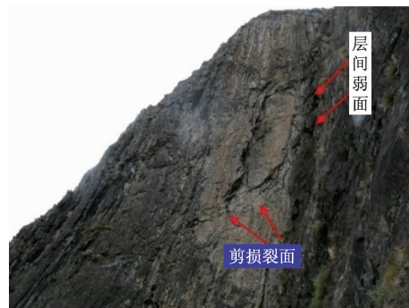
图9 右岸斜坡蠕滑-剪切破坏模式
