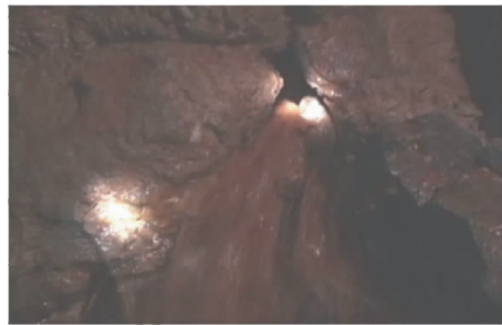
图 20 PDK354 + 435 揭示 2 # 溶洞的宽约 0.3 m
