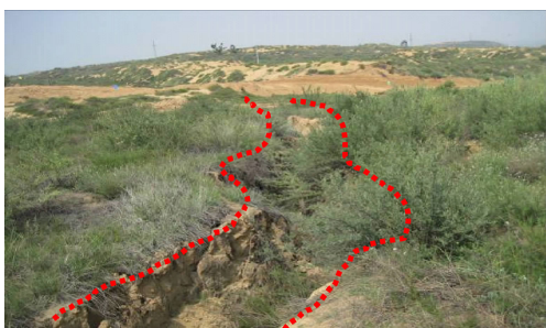
图4 榆阳区永乐煤矿范围内的塌陷槽
