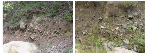
图 4 上疙瘩沟坡面崩滑物 Fig. 4 Collapsed and slid material in Shanggeda gully
