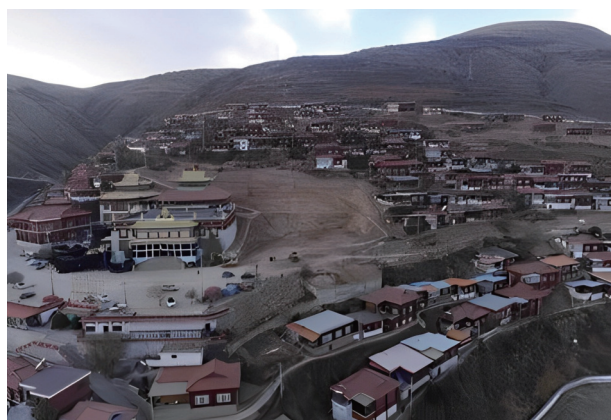
图 1 边坡全貌图(镜像 318°)
