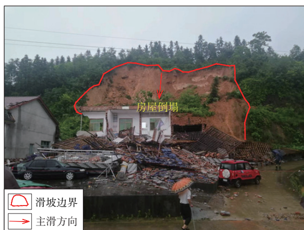
图5 滑坡全貌及倒塌房屋
