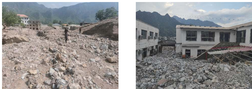
(a) 保定市涑水县三坡镇马庄村西沟泥石流 (b) 保定市涑水县三坡镇上庄村东港沟泥石流
