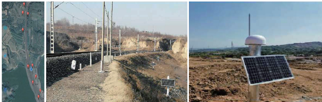
(c) 铁路沿线地质灾害监测点布置及监测设备 [7]
