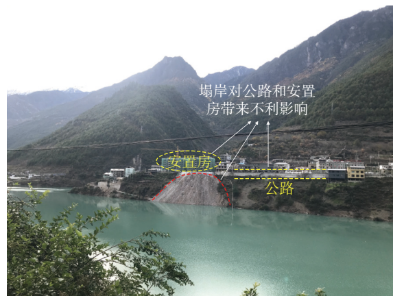
图 2 茨中村安置点前缘塌岸现象
